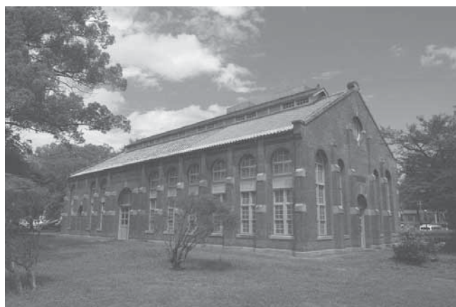
災害復旧工事が完了し公開された工学部研究資料館 （壁面に連続アーチ窓と控壁が交互に並ぶ）
